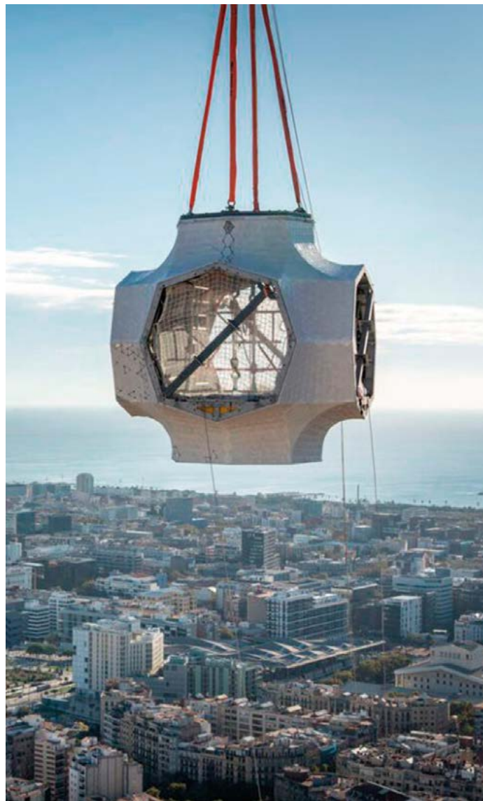
El montaje del núcleo y de los brazos de la nueva torre de Jesucristo ha resultado en sí mismo una obra monumental, como el proceso de fabricación del vidrio en Cricursa.
