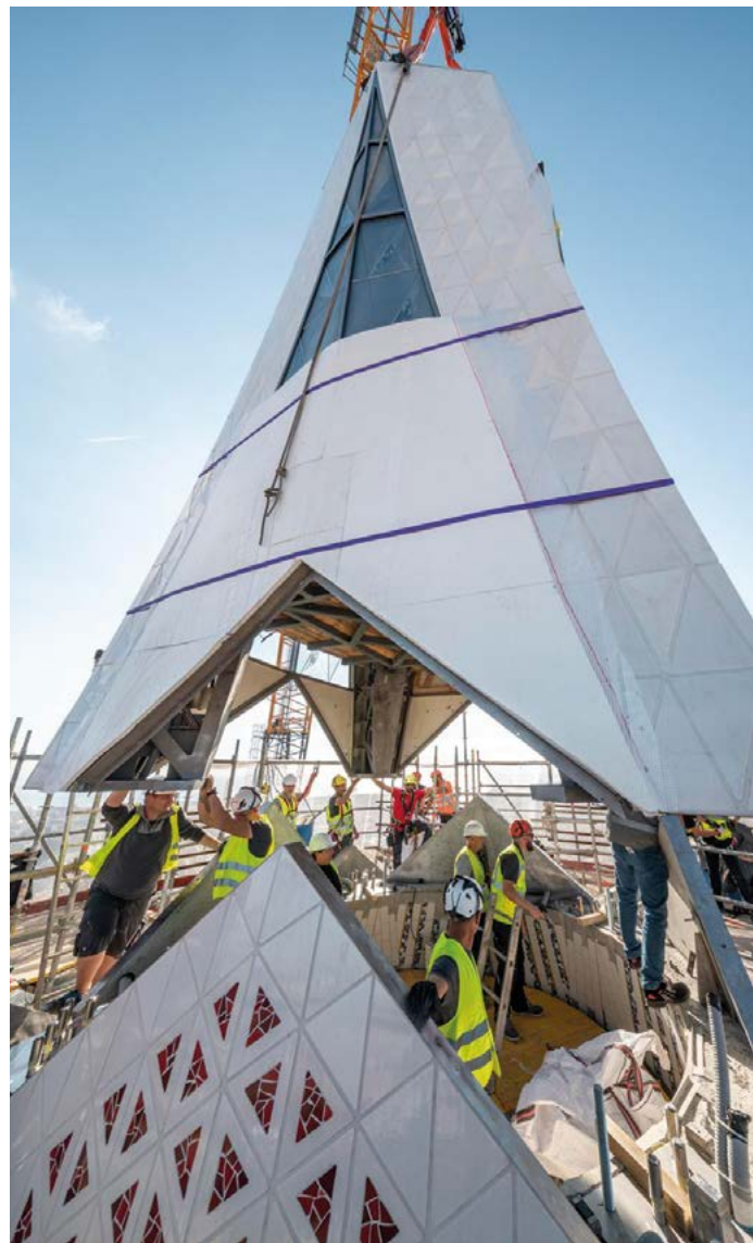
El montaje del núcleo y de los brazos de la nueva torre de Jesucristo ha resultado en sí mismo una obra monumental, como el proceso de fabricación del vidrio en Cricursa.
