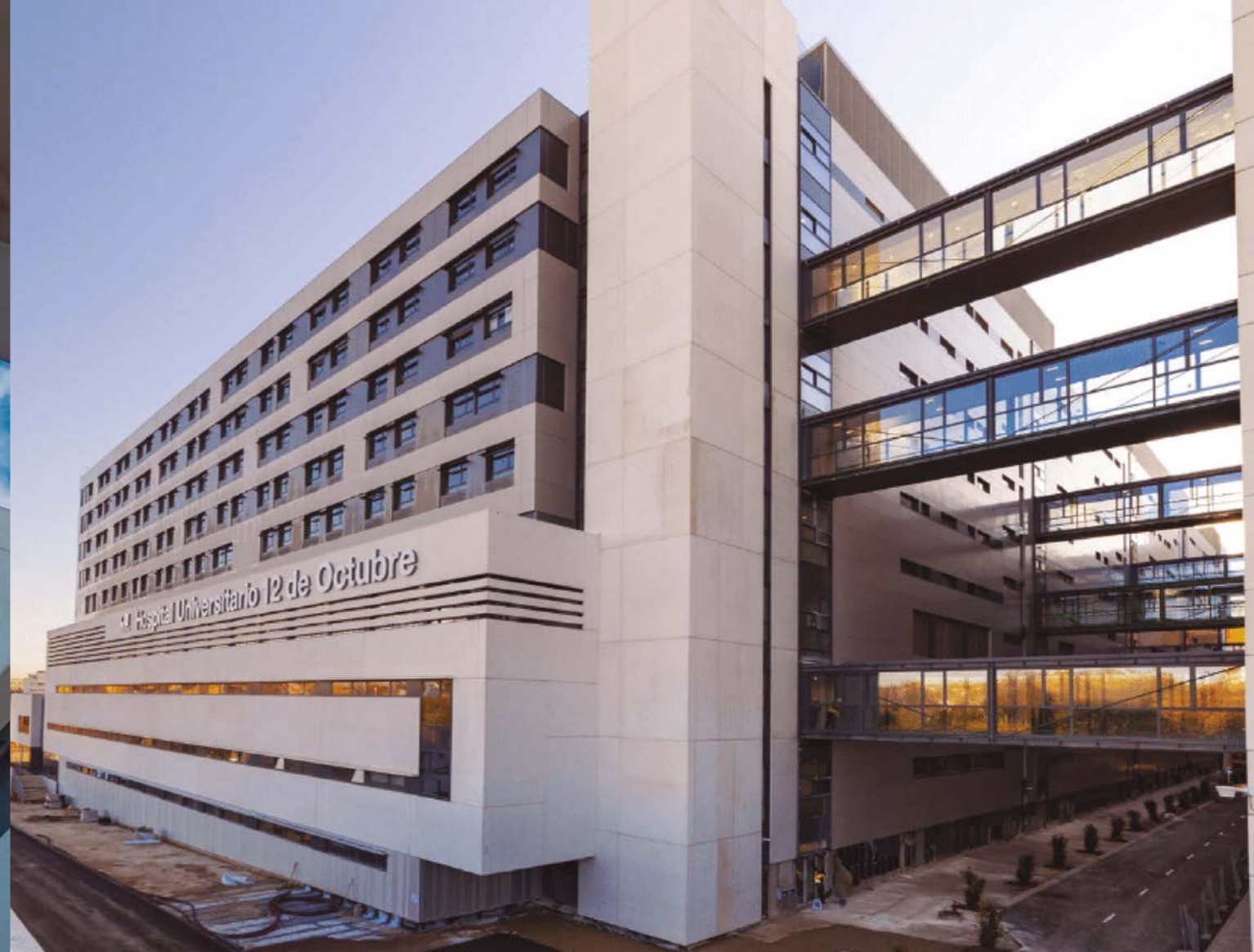
El exterior del nuevo ala del hospital con la serie de pasarelas acristaladas que permiten la comunicación con el edificio fundacional.
