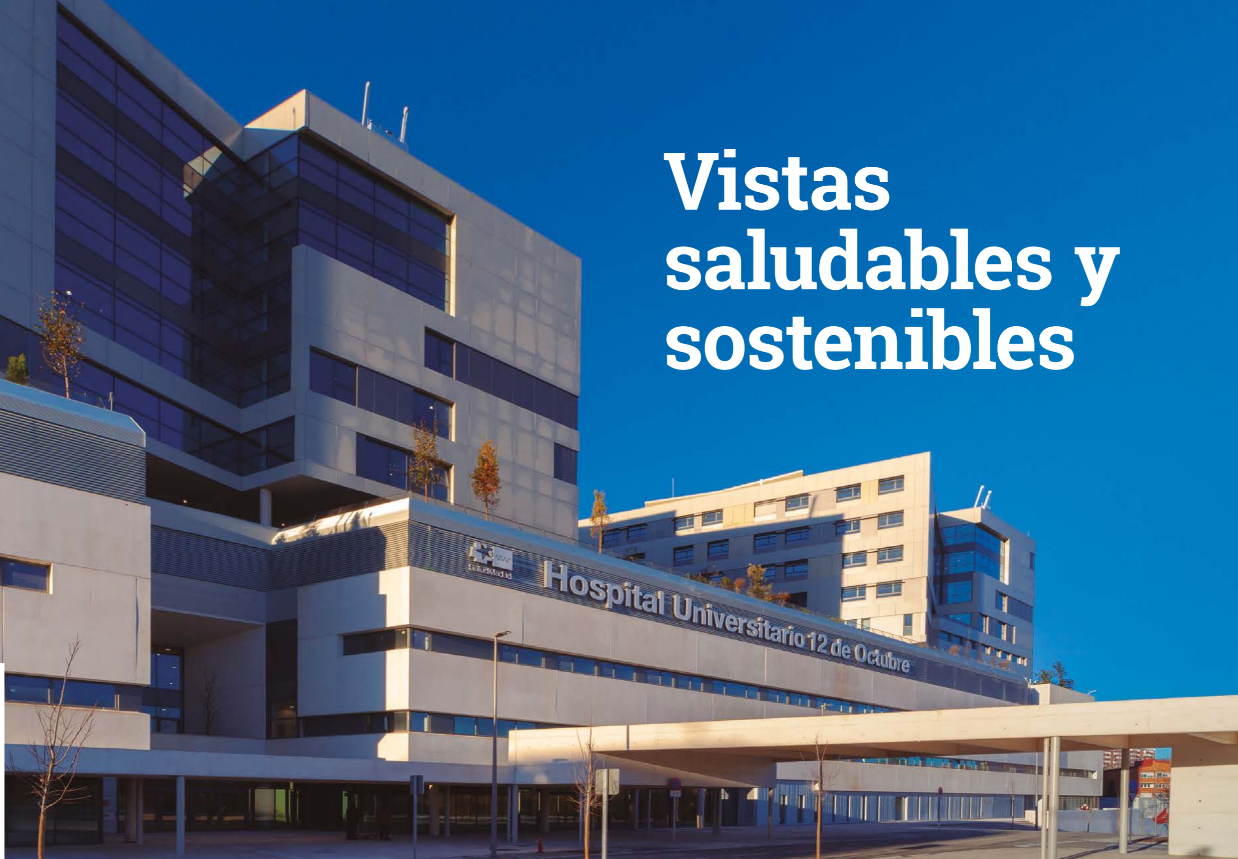
Tvitec ha fabricado para el proyecto de Sacyr en el renovado Hospital 12 de Octubre no sólo el acristalamiento de los muros cortinas, sino también toda la ventanería de altas prestaciones.
