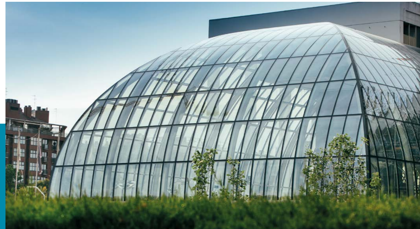
En las obras de remodelación del auditorio valenciano, bajo la dirección arquitectónica de la firma Santatecla, se invirtieron 12 millones de euros.
