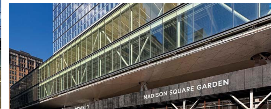
Para el podium de 2 Penn, sobre el Madison, se fabricaron piezas de hasta 6 metros muy transparentes.
