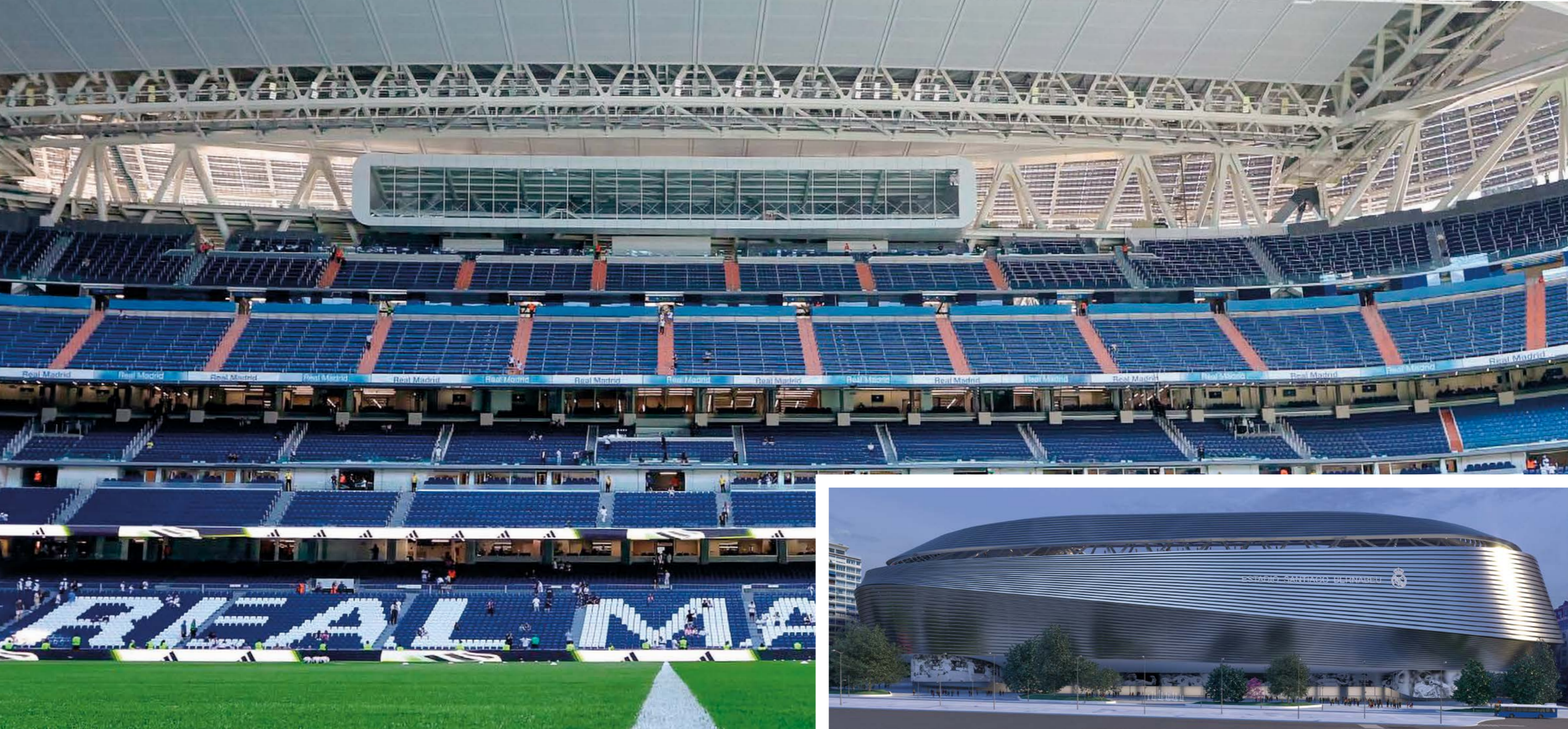
En el interior del estadio, además de los palcos y barandillas, en la cúspide destaca el acristalamiento con vidrios gran formato del Sky Bar en el que lucirá un restaurante panorámico.
