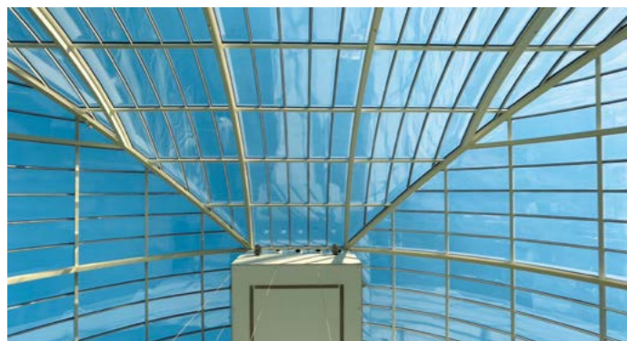
Para el acristalamiento de la bóveda del Palau se fabricaron cerca de 3.000 metros cuadrados de vidrio curvado de altas prestaciones. La eficiencia energética está garantizada.
