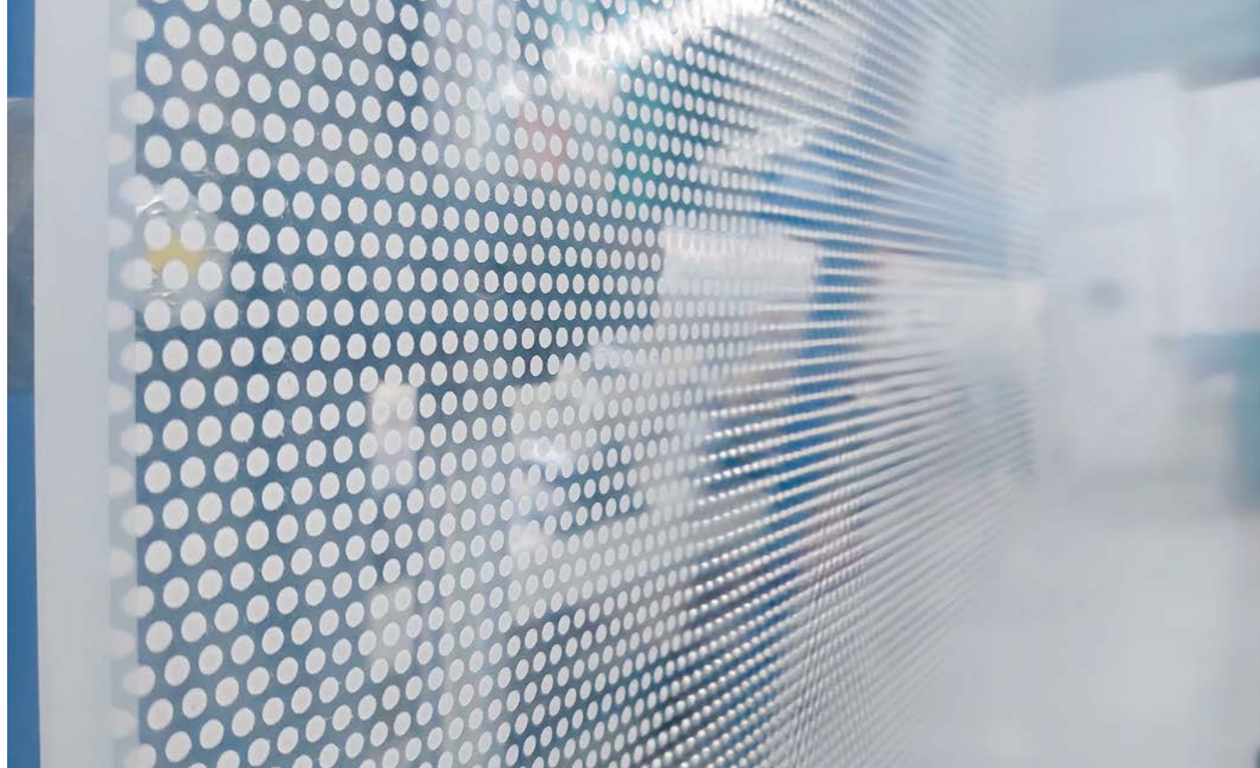
En la imagen superior, una de las piezas que se fabricaron para una de las partes acristaladas del estadio con serigrafía digital de puntos blancos y una manufactura perfecta.
