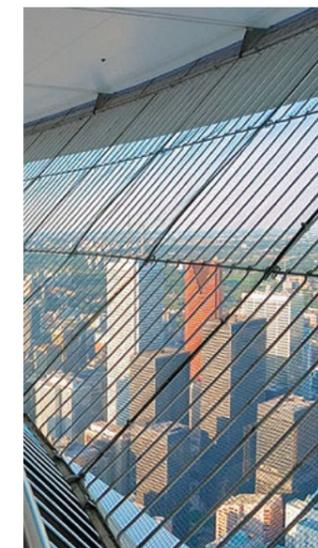
Las piezas multilaminadas en la planta de Cricursa incorporan un filamento muy sensible que activa la calefacción de los vidrios que se instalarán en el famoso mirador público.
